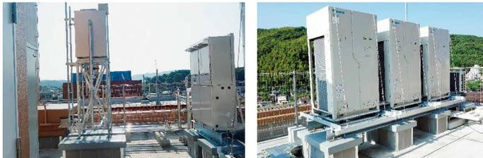
屋内消火栓用充水タンク及びガス給湯器（災害時ガス供給は、都市ガス供給会社にてバックアップを行う。）
