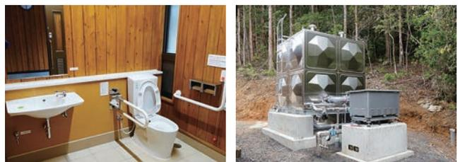
写真5・6 多目的トイレ及び受水槽・自動給水ポンプ
