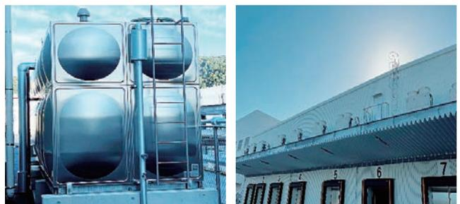
写真6・7 ステンレス水槽一体型屋外消火栓ポンプユニット、空調室外機
