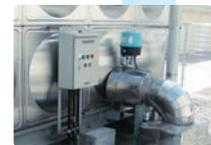
緊急遮断弁システム
