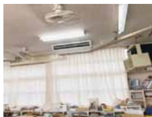
写真 5 室内機設置状況
