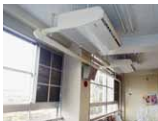
写真 4 室内機設置状況
