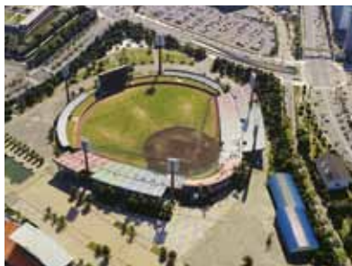
【県立鴨池野球場 全景】
