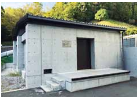
写真② LPボンベ貯蔵庫 50kgボンベ×130本常時備蓄
