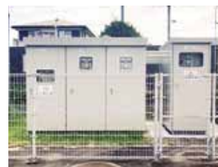
写真 6 屋外キュービクル増設状況
